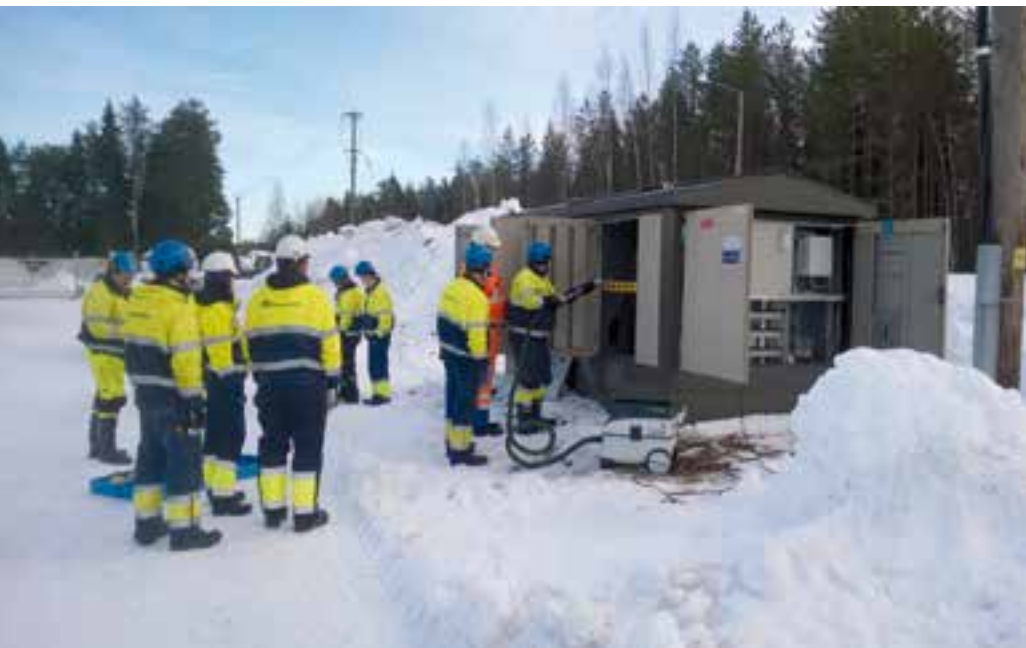
JT 20 kV jännitetyöimurointia. Koulutus 10.2.2015.
