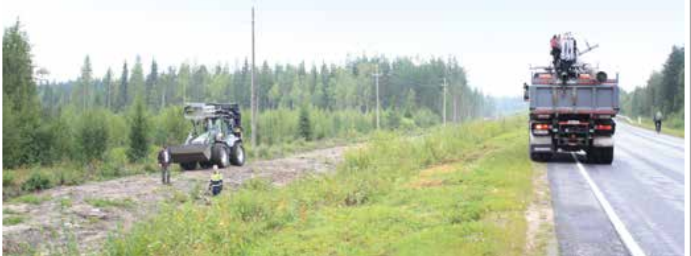
Kuivalanperän pumppaamon muuntajan (nro. 310) rakennustyömaa
